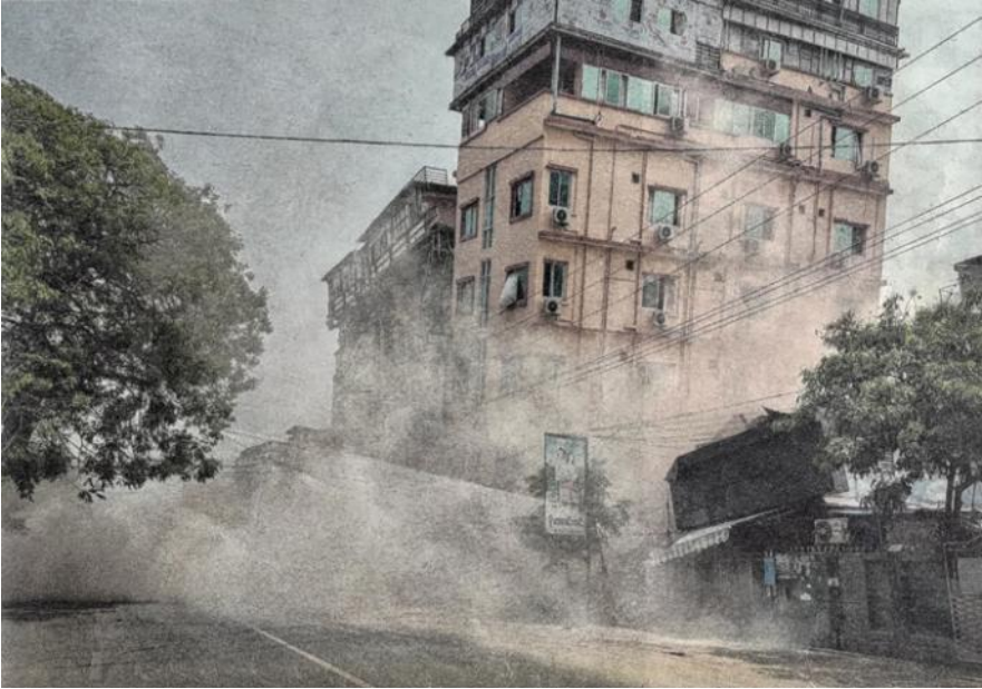
En bygning i millionbyen Mandalay i Myanmar, lige før den styrter sammen under jordskælvet i marts. Foto: AFP/Ritzau Scanpix
